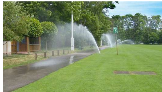
Abb. 27: Falsch bzw. ungenau eingestellte Regner
